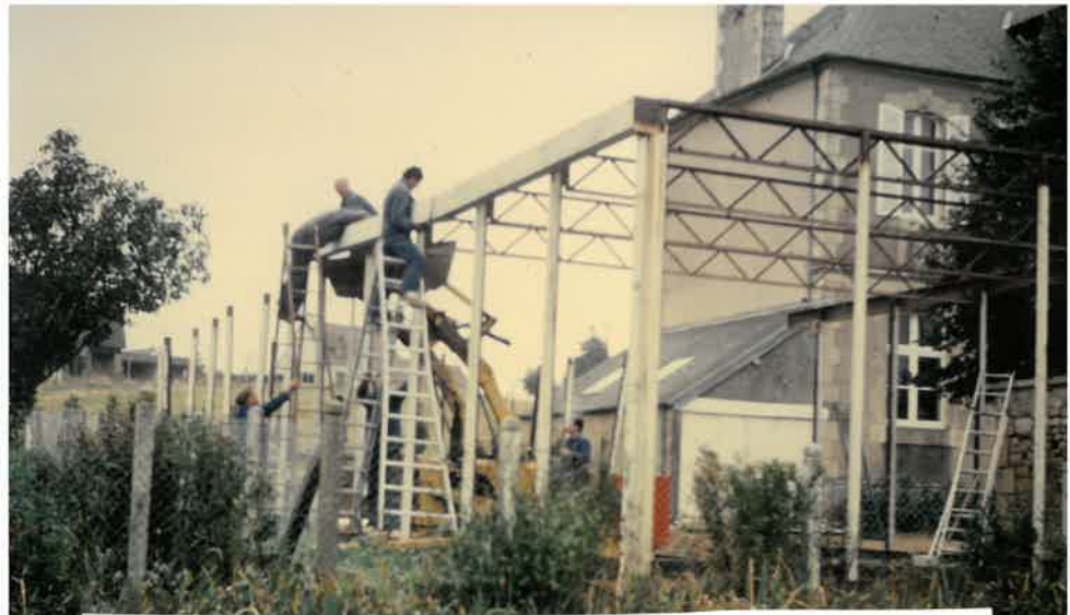
"La construction de la salle des Fêtes" 26 OCTOBRE 1985
